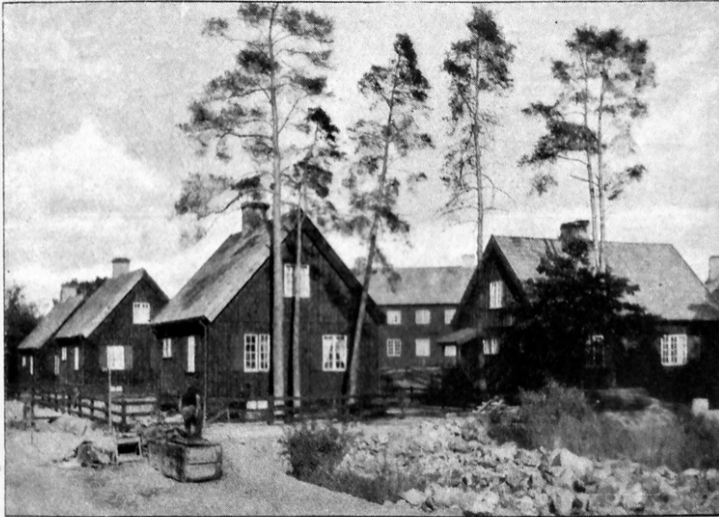
194. Af staden uppförda byggnader i Kungsholms villastad.
